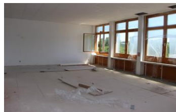
Erneuerung aller Naturwissenschaftsräume im F-Gebäude
