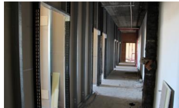
Neuer Verwaltungstrakt mit 6 neuen Büros für unsere Schulleitungsmitglieder
