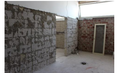
Neugestaltung der Schülertoiletten im F-Gebäude
